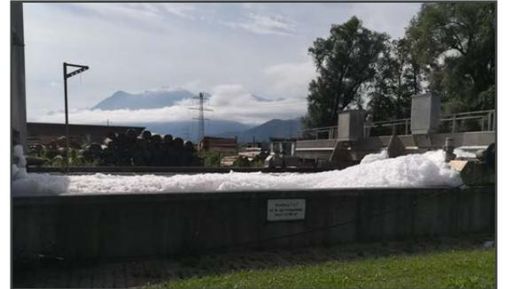
Bei obigen Bildern wurde etwas Falsches in den Kanal eingeleitet - sämtliche Höhenstandsmessgeräte spielten verrückt und alles schäumte.
