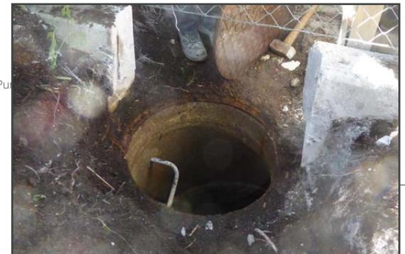
Hier ist ein Tellerbelüfter geplatzt. Es mussten 2250m<sup>3</sup> Belebtschlamm umgepumpt werden. Das Becken (60m lang 10m breit 5,5m tief) und alle Lüfter wurden gereinigt/repariert ohne das der Reinigungsprozess je unterbrochen wurde.
